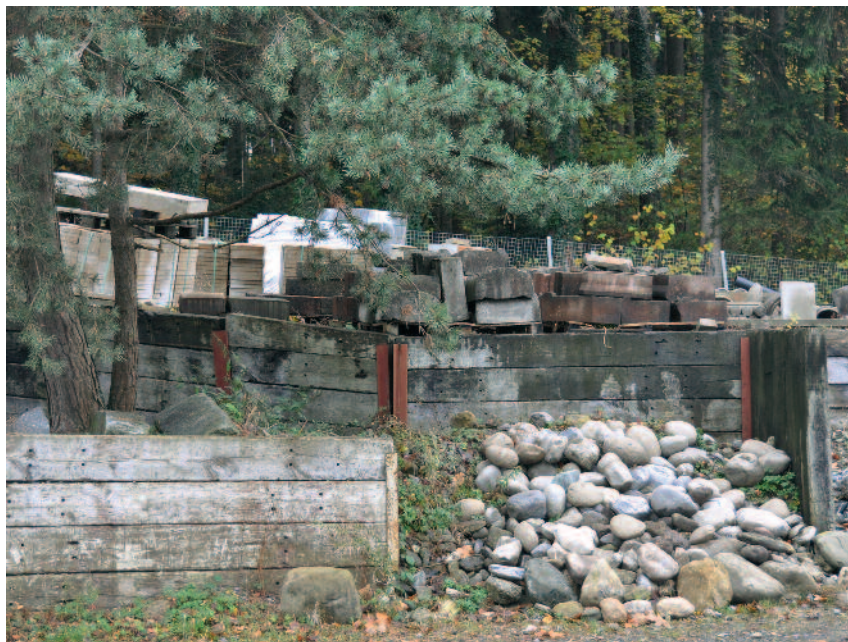
Nicht nur mit einer guten Büroorganisation liesse sich Zeit sparen, sondern auch mit übersichtlicher Lagerung auf dem Werkhof.
